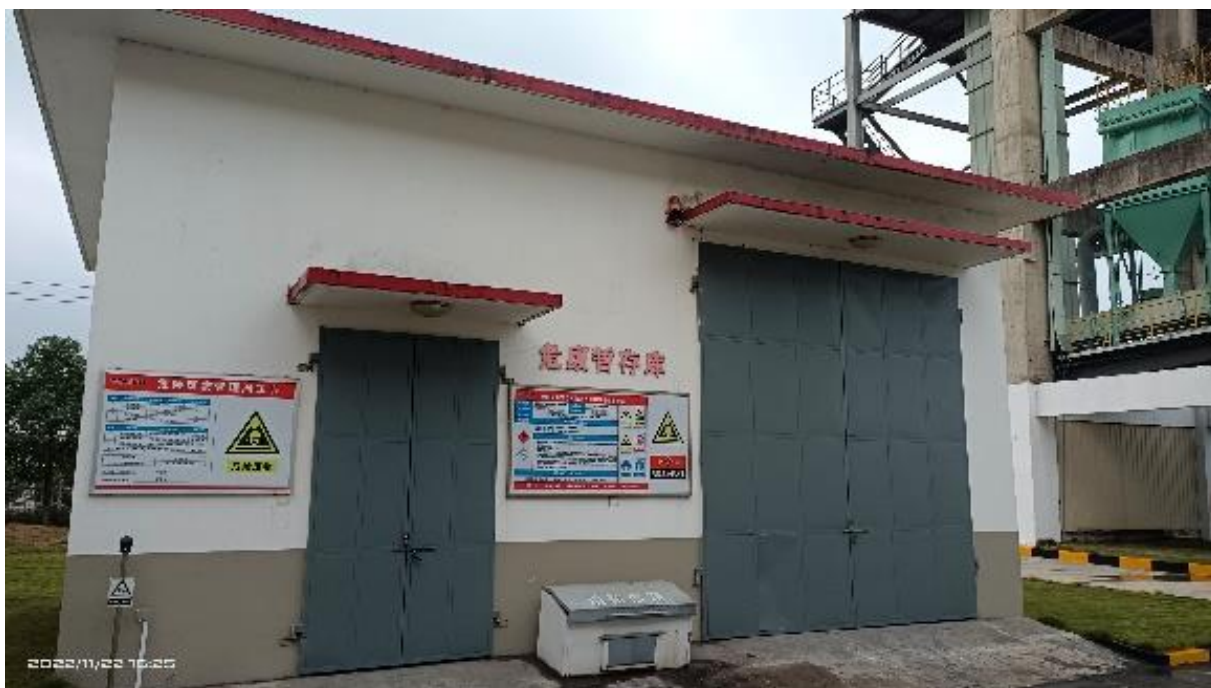
图 10.2-1 厂区危废暂存库
